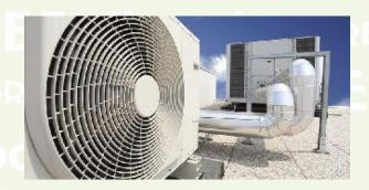
Estos equipos basan su funcionamiento en el accionamiento mecánico de sus componentes y el trasiego de fluido, por lo que es fácil que estas instalaciones sean habitualmente posibles focos de ruido (aéreo, de impacto y/o vibraciones).
